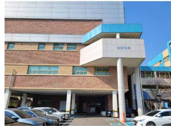
제품 설치 후
